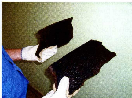
Фото 1. Железоокисный шлам с поверхностей деаэратора и аккумуляторных баков
