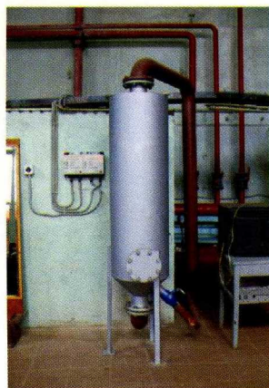
Фото 7. Общий вид грязевика «ГИГ-90»
