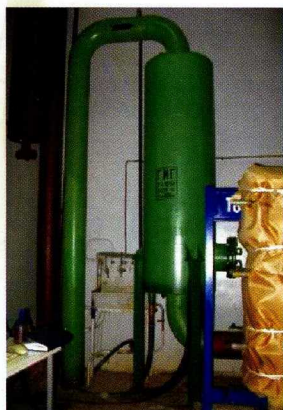
Фото 2. Общий вид грязевика «ГИГ-225»
