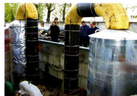
Фото 5. Дренажная вода из грязевика «ГИГ-225». Аппаратом уловлена нерастворившаяся хлорная известь
