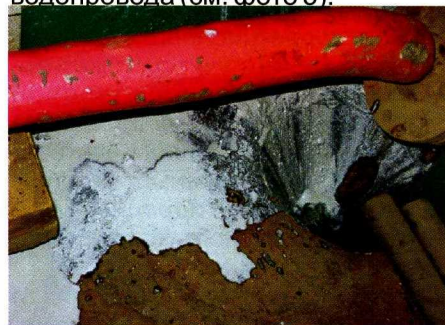
Фото 5. Дренажная вода из грязевика «ГИГ-225». Аппаратом уловлена нерастворившаяся хлорная известь
