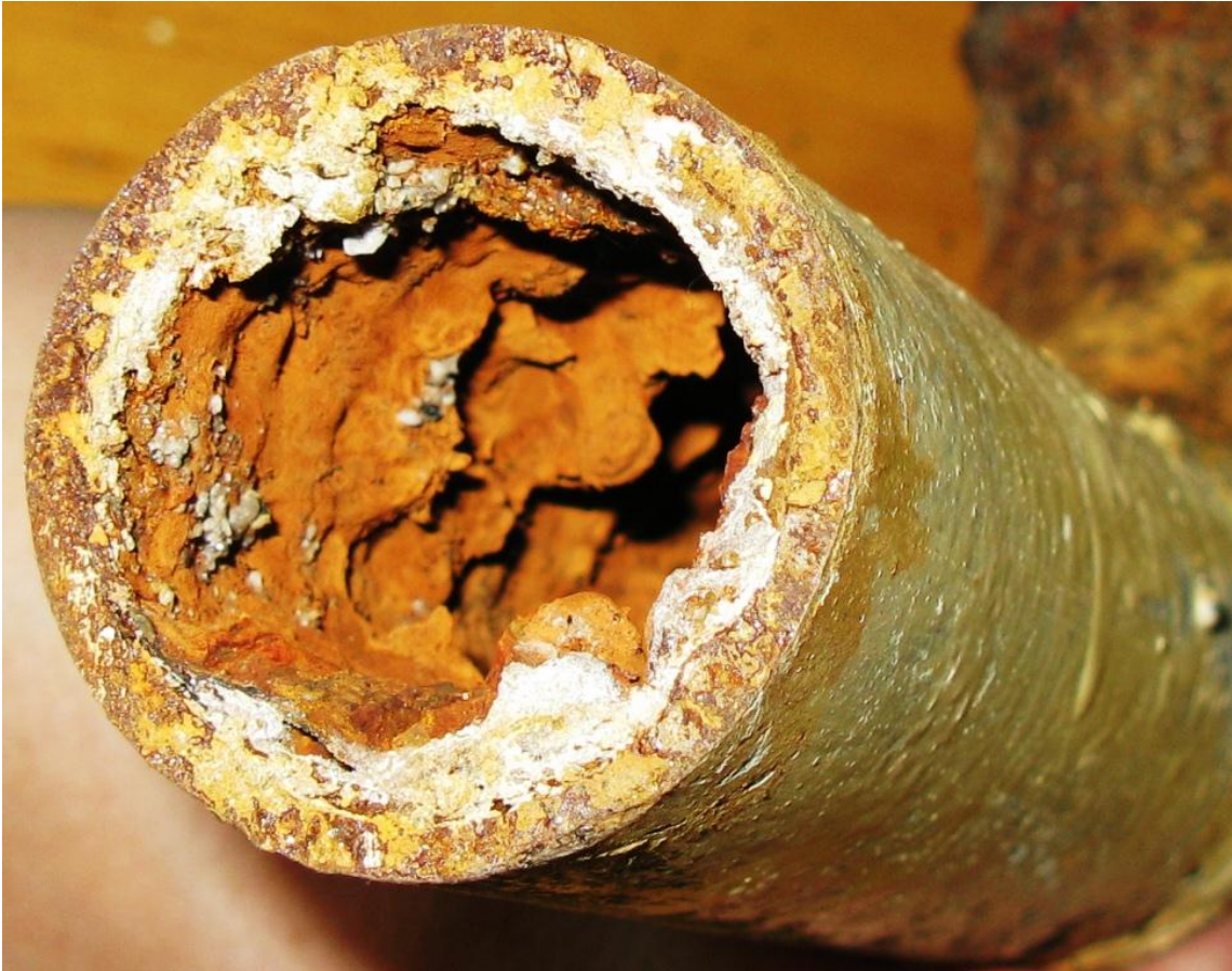
Состояние трубопроводов системы теплоснабжения в начале отопительного сезона. (Сентябрь 2009 г.)
