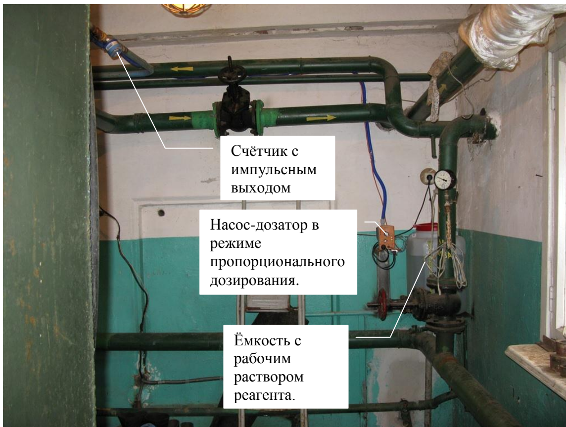
Установка дозирования реагента пропорционально расходу подпиточной воды.
