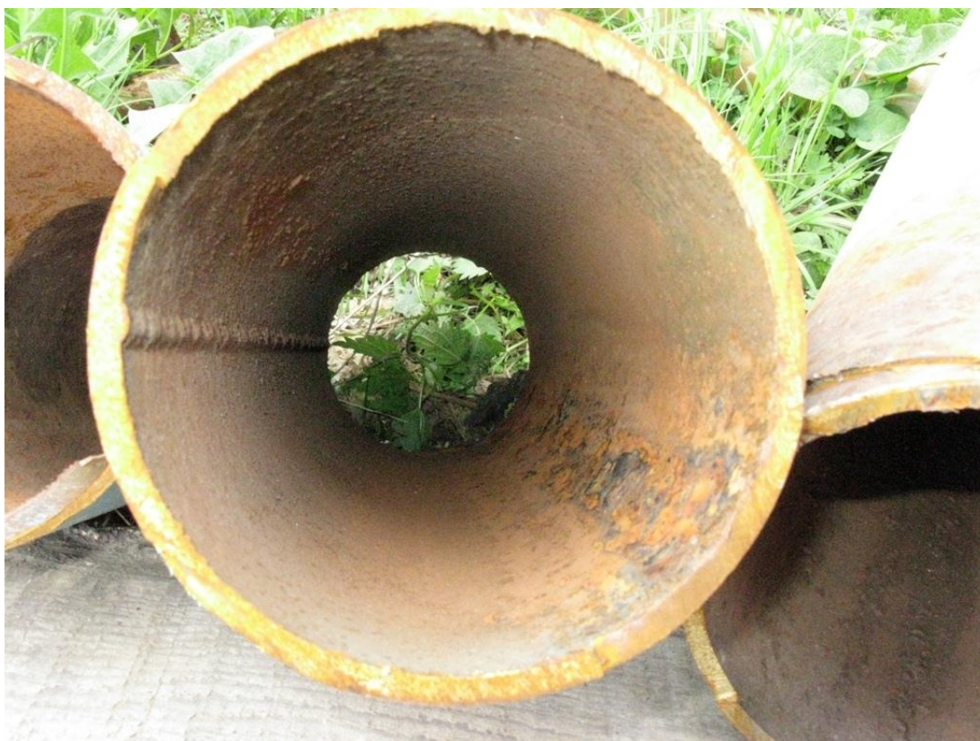
Магистральный трубопровод теплосети. Май 2010 г.
